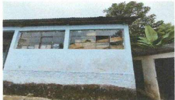
Foto 4: Instalación de balcones de metal en las ventanas de la Dirección del plantel para seguridad de los bienes y materiales didacticos.
